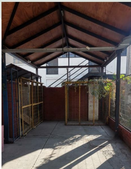
Retiro de estructura metálica donde se ubicaban cilindros de la antigua red de gas.
