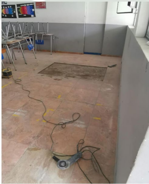
Reparación de piso cerámico sala 16. Etapa 2
