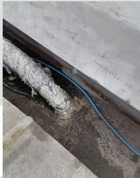
Sellado de canaletas de aguas lluvias del auditorio
