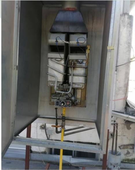
Reparación de calefont que suministra agua caliente al camarín de niñas y personal de Junaeb
