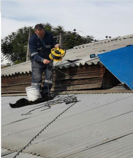
Reparación techumbre oficinas de psicopedagogía e imprenta
