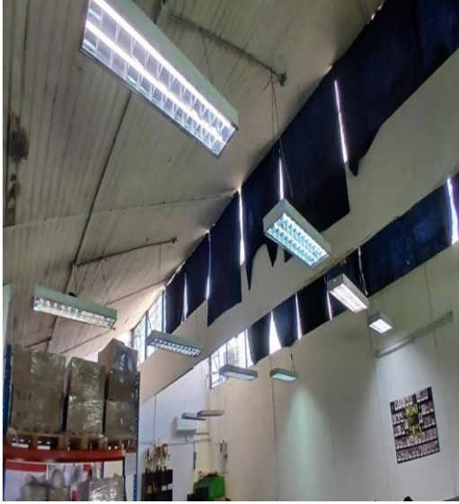
Reemplazo de equipos fluorescentes por equipos led en sala de Administración mención Logística
