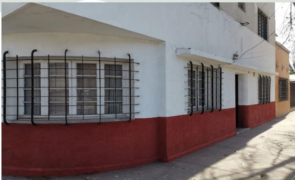
Pintura de muros exteriores de la casa esquina
