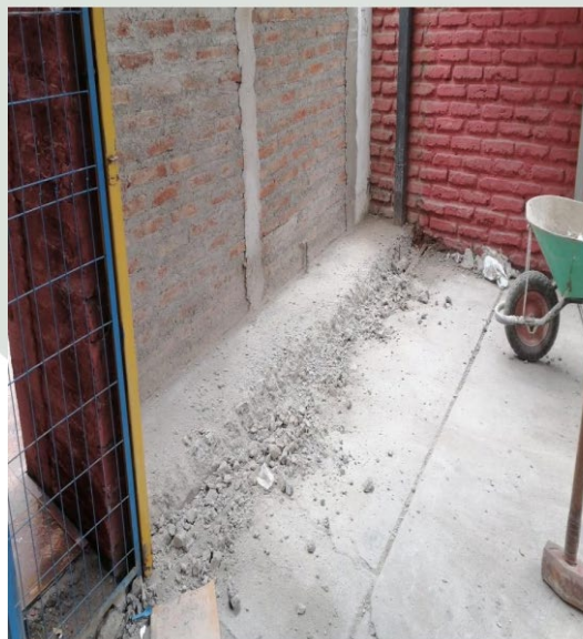
Nivelación de piso para montaje de oficinas modulares
