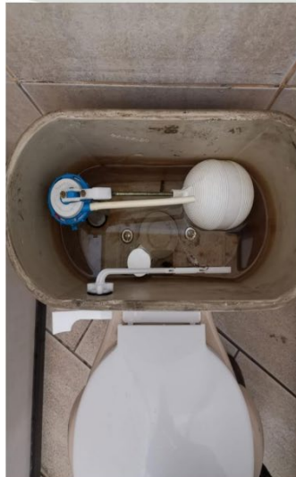
Reparación de 3 WC con filtraciones, ubicados en baño de profesoras y baño de discapacitados
