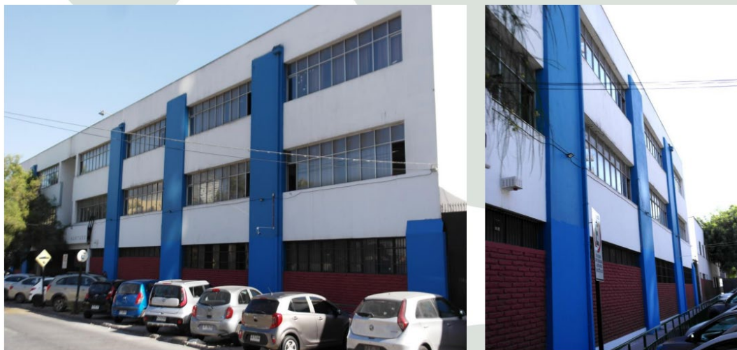
Pintura de muros exteriores del establecimiento
