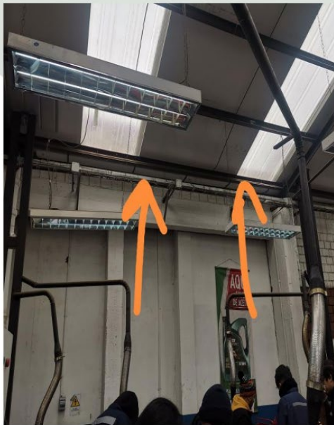
Reparación de filtraciones de la cubierta nueva del taller de Mecánica Automotriz (Garantía)
