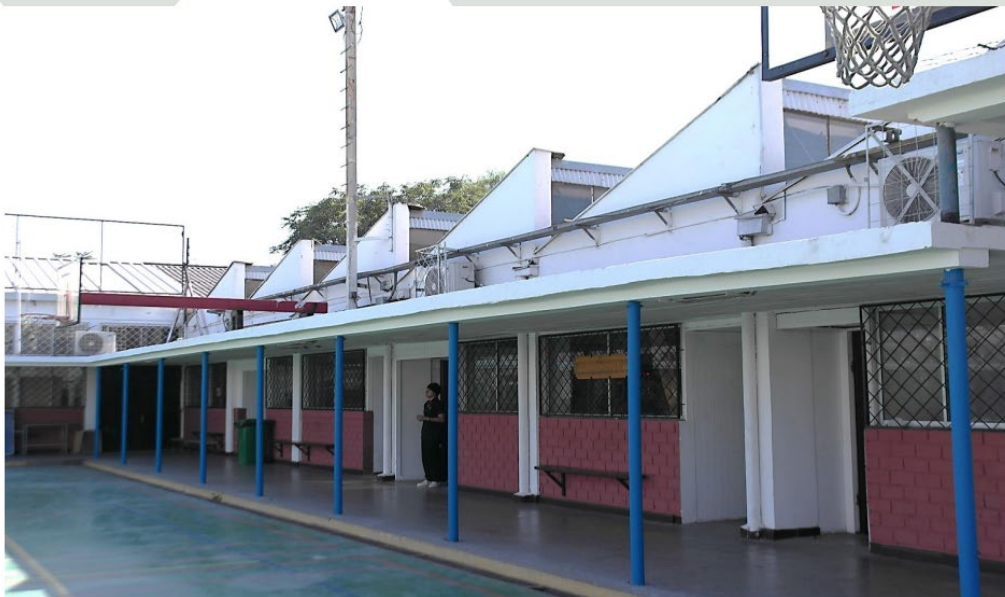
Pintura de muros ubicados sobre la loza del 2° patio
