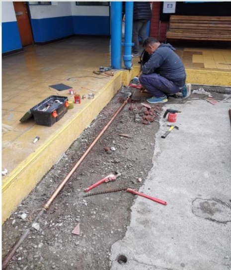
Reparación de fuga en red de agua potable interior
