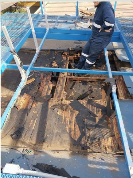
Reparación de techumbre ubicada en loza del primer patio
