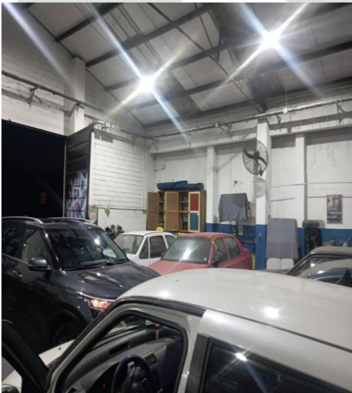
Instalación de proyectores de área led en taller de Mecánica Automotriz, sector ajuste de motores
