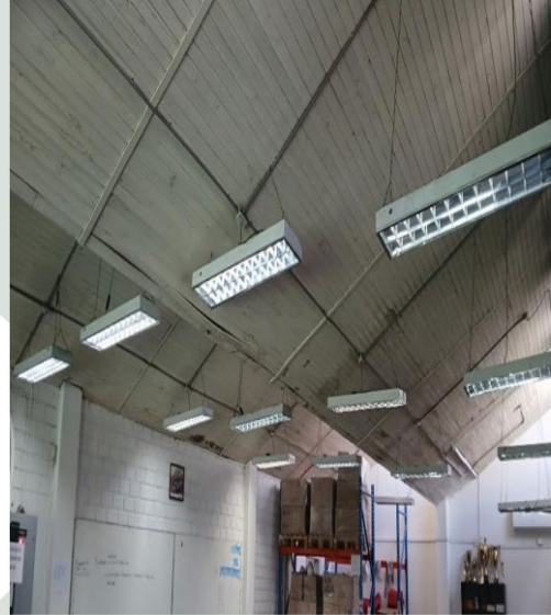
Reemplazo de equipos fluorescentes por equipos led en sala de Administración mención Logística
