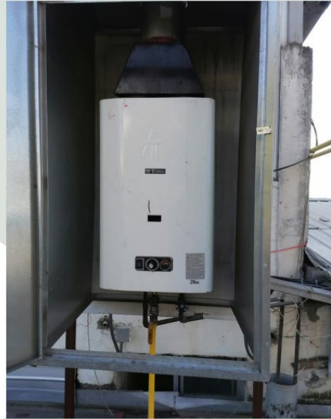
Reparación de calefont que suministra agua caliente al camarín de niñas y personal de Junaeb
