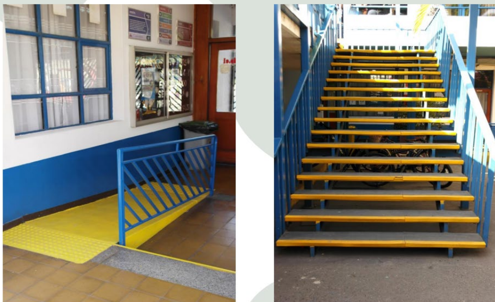
Pintura rampas de acceso universal y demarcación de escaleras
